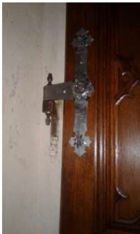
Po restaurování – východní vchod
